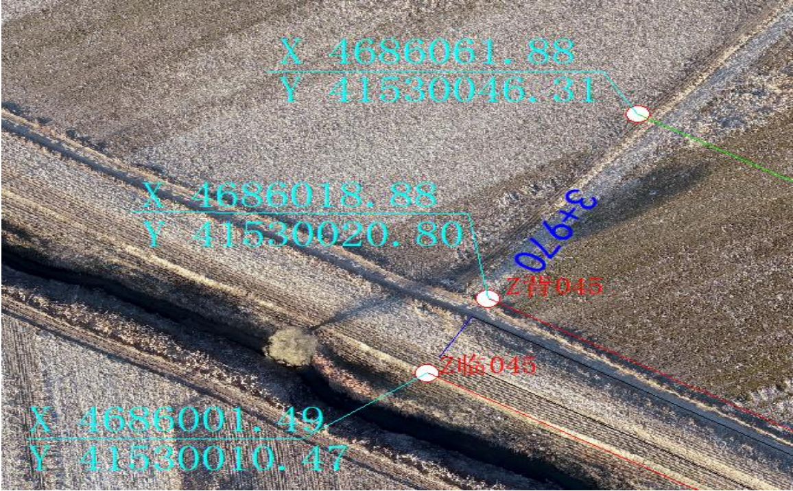
图 4-3 下游左堤防起点位置
